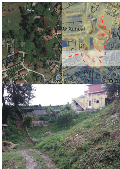
FIGURA 3. Labor Regueiriño do Caeiro, en Baiona. Abaixo, vista parcial da corta mineira. Arriba, traza aproximada da corta mineira na ortofoto de Google Earth e no mapa de pendentes.
