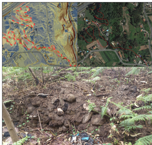
FIGURA 4. Labor das Insuas, en Baiona. Abaixo, muro de contención feito de croios graníticos da zona que indican forte meteorización. Arriba, traza aproximada da corta mineira na ortofoto de Google Earth e no mapa de pendentes.
