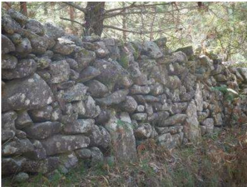
Muros de peche de pedra seca na zona do P.E. Toróña.
