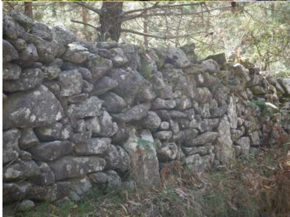
Muros de peche de pedra seca na zona do P.E. Torroña.
