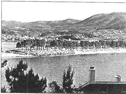
En plena etapa democrática, a principios de 1979, e con obxecto de protexer e ampliar a propiedade privada da Ladeira, volvéronse a verter grandes cantidades de pedra sobre o dominio público da praia, construíndose deste xeito un dique artificial onde antes había praia.
