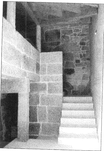
Vista parcial da rehabilitación da casa Valcarce. Peitxeiros, ano 2002.
