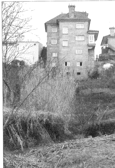
Inadecuación tipolóxica e volumétrica, recente, emprazada no medio rural.
