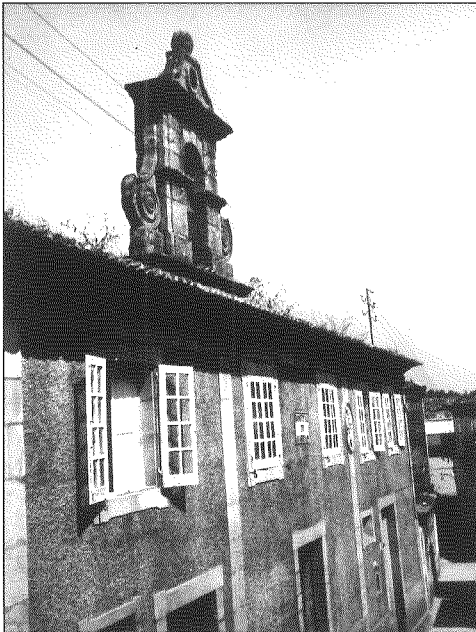
Fachada á rúa M. Valverde, tamén chamada do Hospital de Caridade co seu campanario barroco (F. Garcés)
