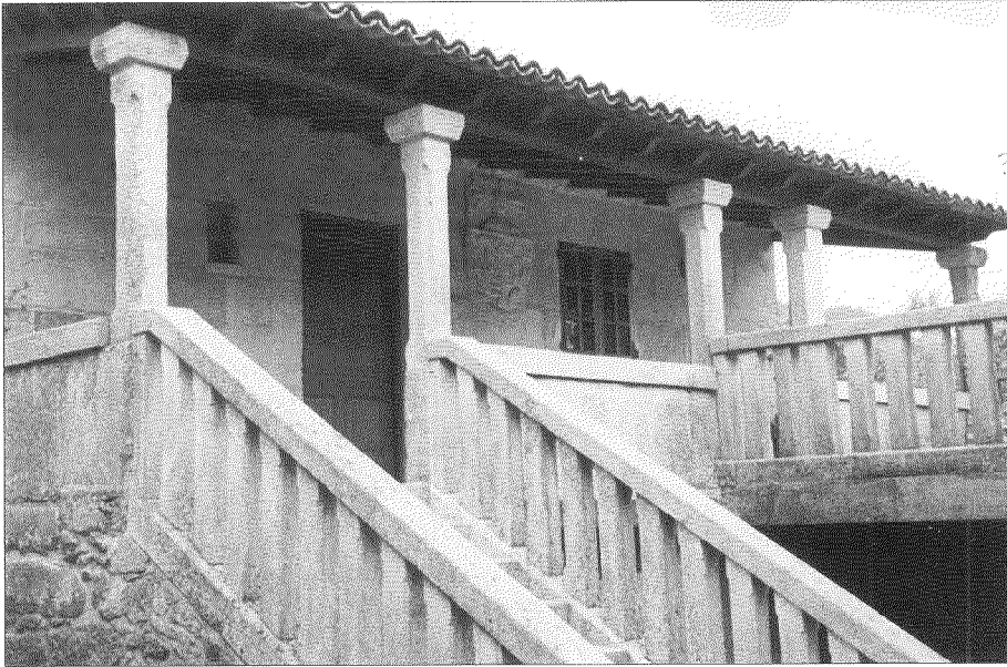
Vista do patio interior.
