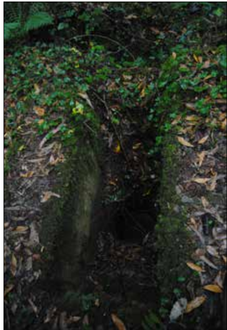
Peza de cantería, co seu oco de descarga, sobre a que se asentaba unha das turbinas da central.
