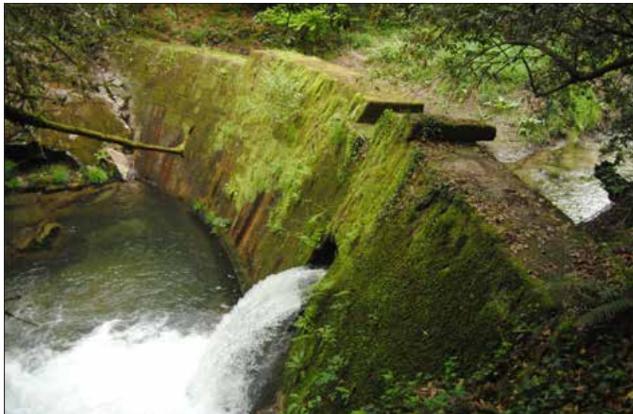
Estado actual da presa do Pego Negro.
