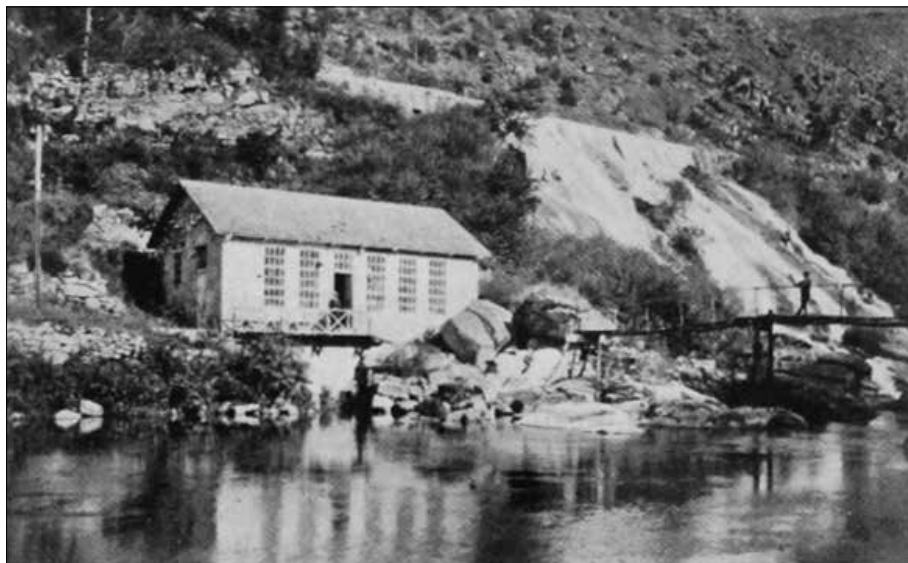
Central do Salto de Aranza (Ponte Caldelas), a 1ª central hidroeléctrica da bisbarra da Ría de Vigo, cara o ano 1922. 18
