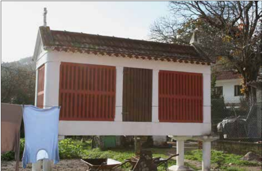
Canizo da Casa de Avelino. O Souto.
