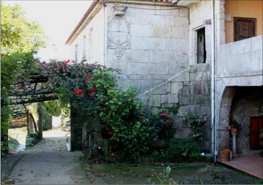
Patio e patín da fachada norte. No ángulo inferior dereito unha antiga columna do corredor.
