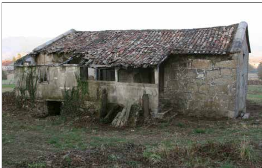
Vista do reformado patín a solpor. Estado en 2004.
