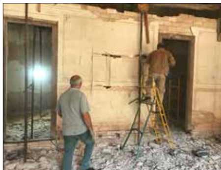
3. Perfórase co taladro toda a parede para comprobar o corte das dúas partes do muro.
