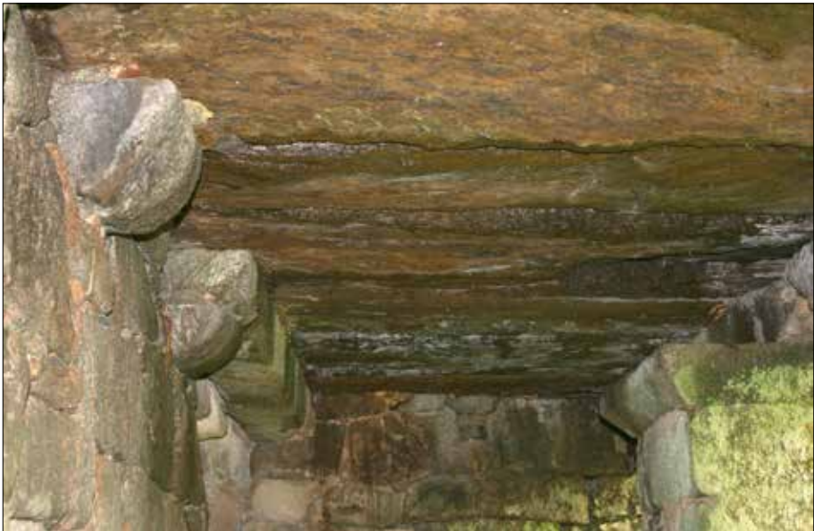
Vista inferior das lousas do pavimento do corredor da Casa de Acevedo, nun tipo de pedra abundante en zonas de Donas e Borreiros.
