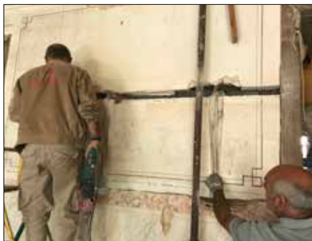
4. Acábase de cortar todo o muro para soltar a peza.
