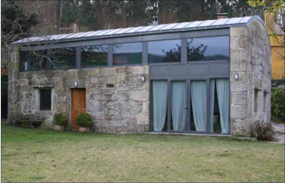
Vista xeral dende o nordés. As agullas, tranqueiros, lintel e peitoril da ventá que existía no pano acristalado foron trasladados para un novo oco da fachada de poñente.
