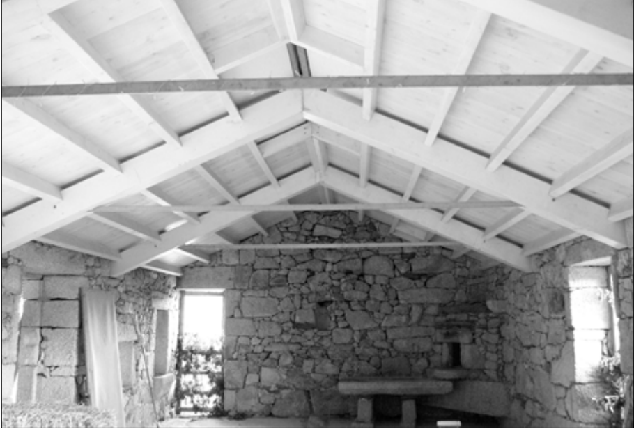
Vista interior da casa vernácula en obras.
