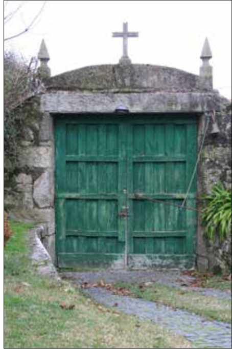
Portal de entrada á finca dende o interior. As portas están construídas utilizando o tradicional sistema de remontas.
