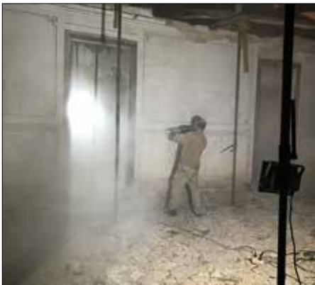
1. Faise un primeiro corte sobre a marca realizada
