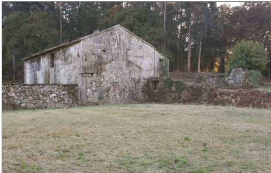
Vista norte coas marcas do desaparecido alpendre. Estado en 2004.
