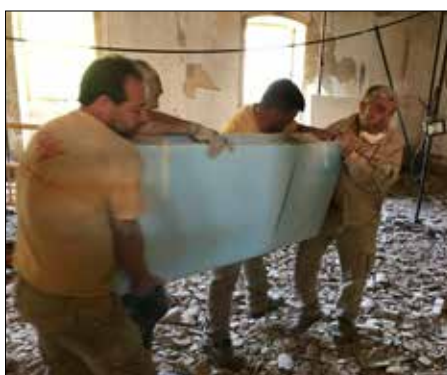
6. Colocación da peza retirada entre dúas pranchas de poliestireno estruído para o transporte.
