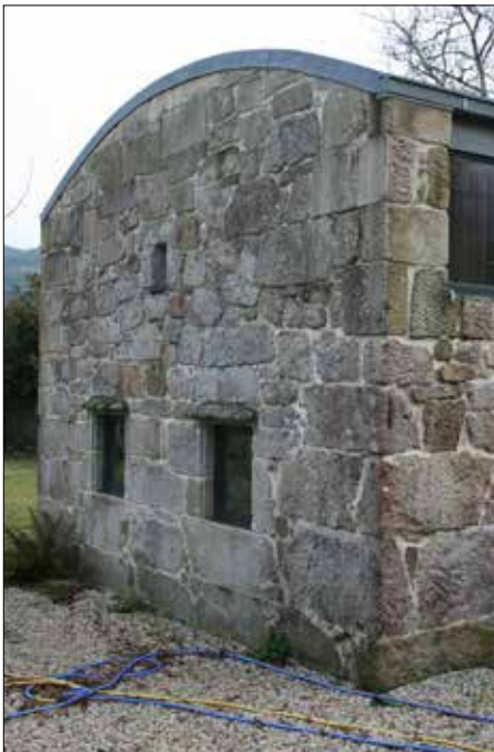
Testeiro norte, no que inda se aprecia a pedra adicionada para acadar altura suficiente para o primeiro andar.
