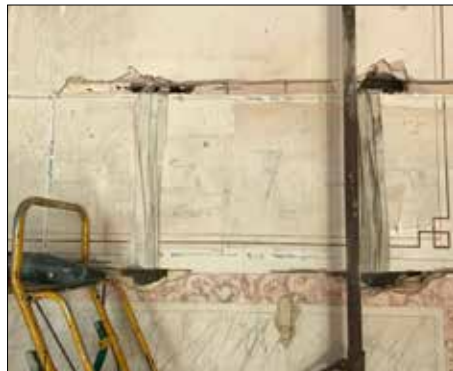
2. Colócanse unhas cinchas para asegurar o fragmento de muro.
