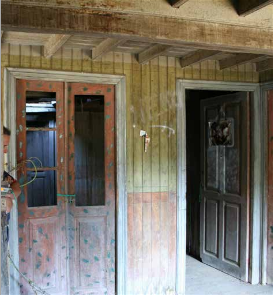
Vista interior dende a sala. Estado en 2004.
