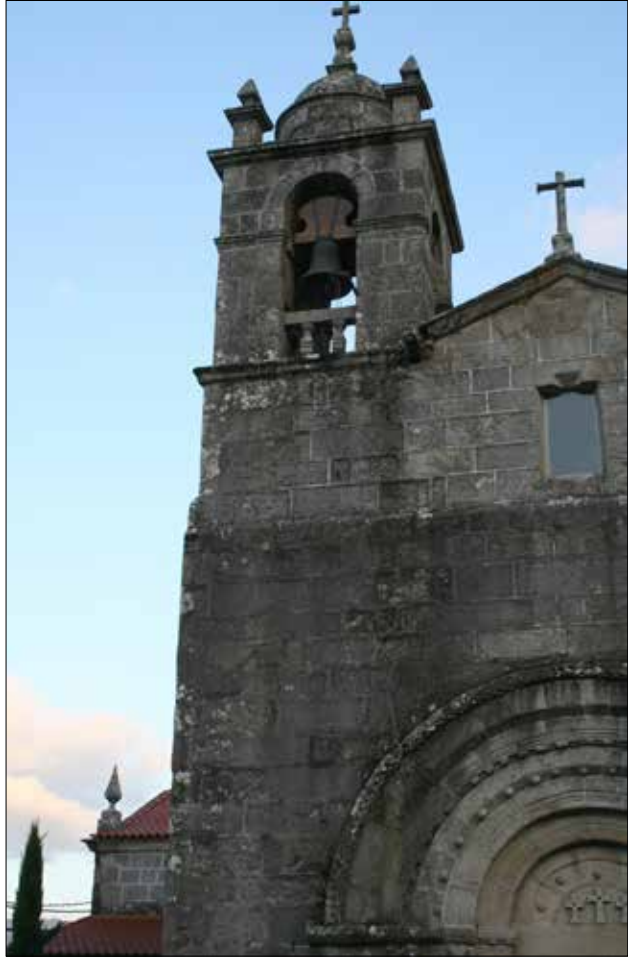
Torre campanario engadida a finais do XVIII. Santa Baia das Donas.
