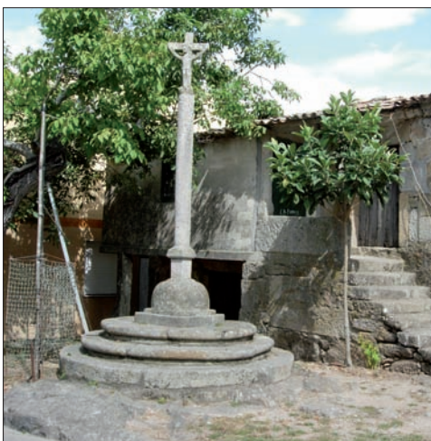
O Cruceiro do Loureiro antes das obras.
