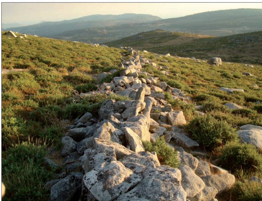
Pared de Foxo Pedriño, foxo de lobo que sofre danos reiteradamente cada vez que se interven na súa contorna.
