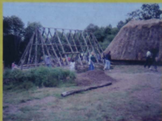
Vista de conxunto con dúas cabanas en diferentes fases constructivas
