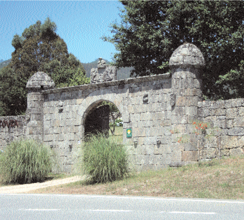
Portalón de entrada. Portalón de entrada. Doorway.
