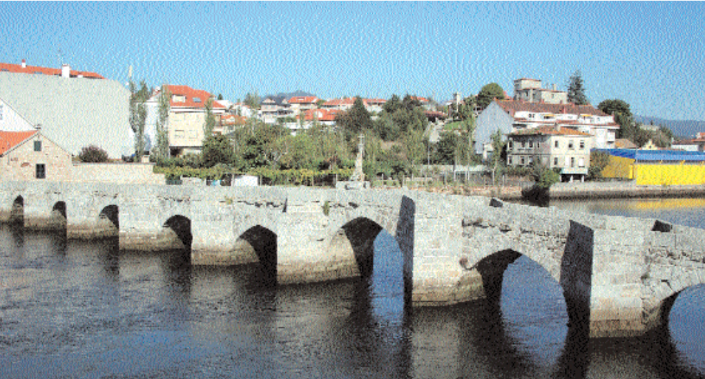
Vista da ponte. Vista del Puente. A view of the bridge.
