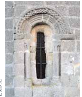
Fiestra da ábsida. Ventana del ábside. Apse window.
