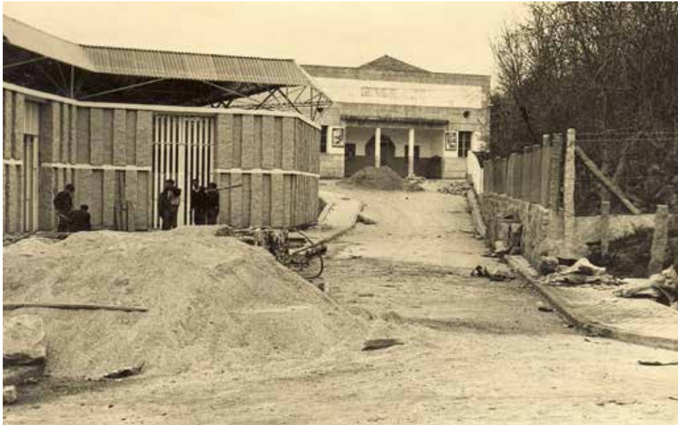
Primeira fase, xa construída, da Praza de Abastos proxectada por Bar Boo na daquela recentemente construída vía de acceso á Primeira Transversal -hoxe rúa Manuel Alonso- dende a Avda Elduayen. Ao fondo o desaparecido Cine Rialto. Ano 1966.
