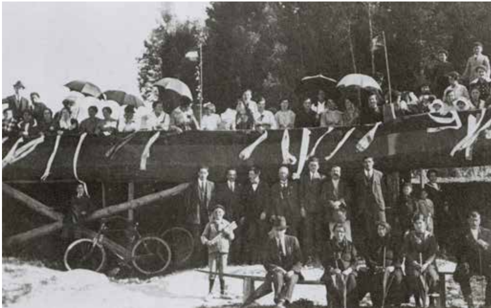
Tribuna e bancos montados para unha "carreira de cintas". Fotografía dos anos 20.
