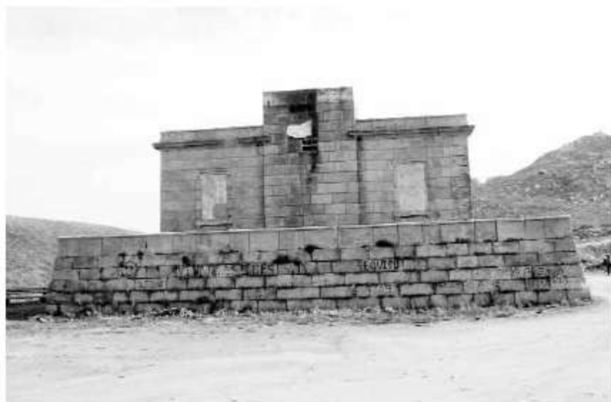
O Faro Vello. Baredo, Baiona.
